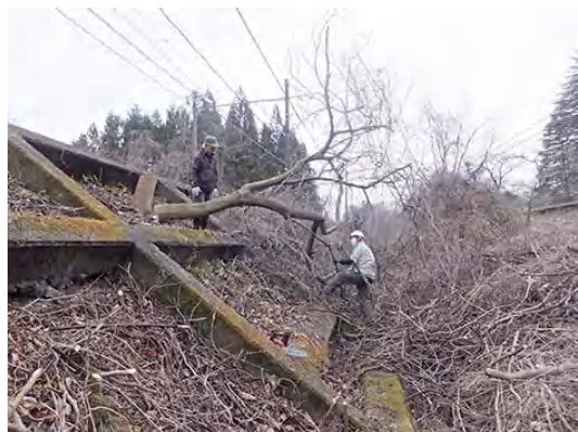
線路敷きの法面に生えた木を伐採しています。
