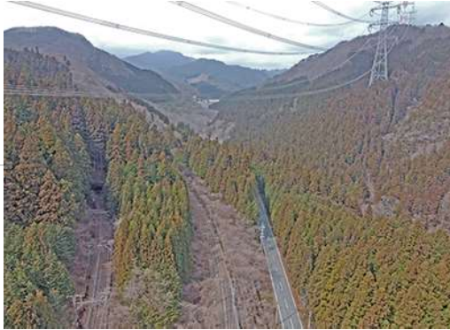
【露天エリアからトンネルへ】 左から下り線2号トンネル入り口、上り線、県道北軽井沢線、山の上の電線は柏崎原発から東京への高圧線
