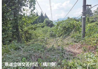
県道立体交差付近（横川側）
