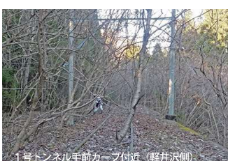
1号トンネル手前カーブ付近（軽井沢側）
