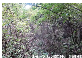
1号トンネル出口付近（横川側）
