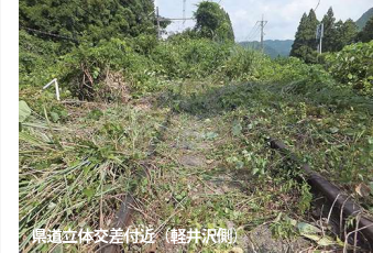
県道立体交差付近（軽井沢側）
