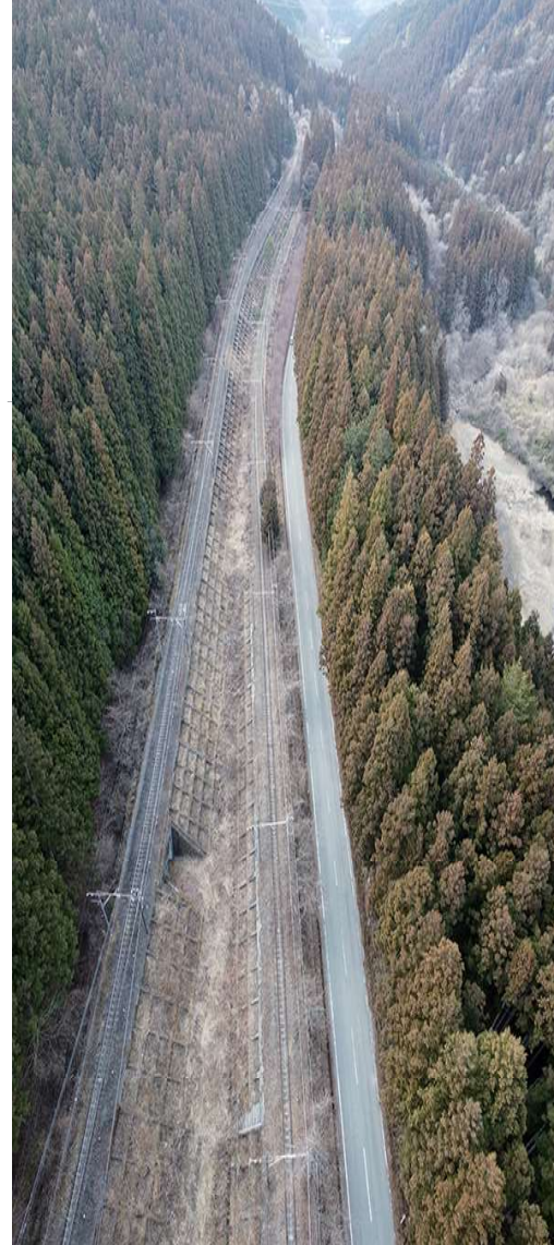
信越本線横川—軽井沢間廃線 1997年9月30日 約400mの区間の景観を再生 2023年3月1日 (撮影:2023年3月1日)
